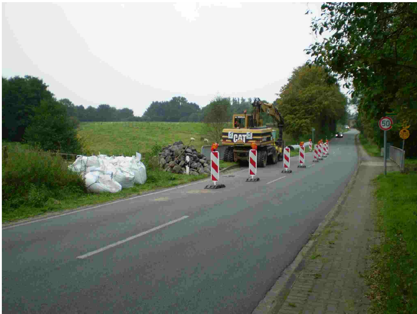
Diese Baustelle an der Brücke bei der Drahtmühle gibt es schon sehr lange. Es ist eine Maßnahme des Kreises. Zur Zeit stehen da immer noch einige Baken. Der Knick hinter dem Bagger wurde geknickt.
