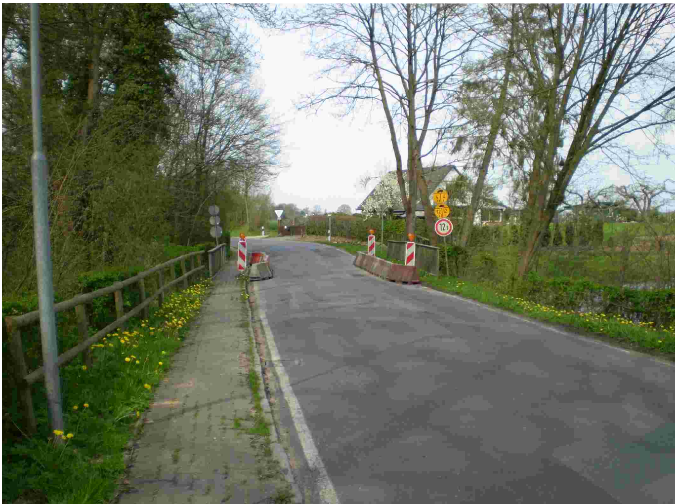
Die Fahrbahn der Brücke wurde künstlich verengt, damit die Belastung für die Brücke verringert wird. Ähnliches gab es schon an der Brücke über die B404.
