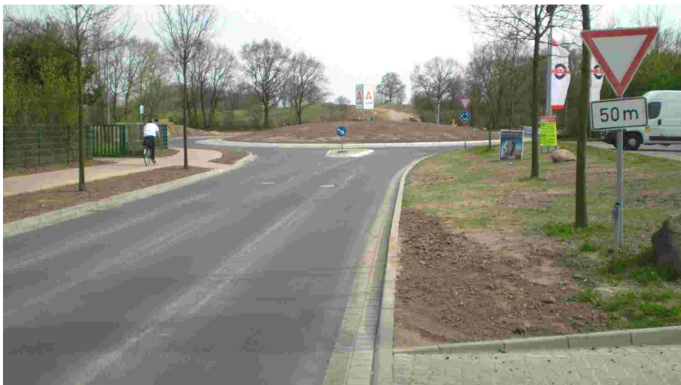
Der neue Kreisverkehr im Industriegebiet in Trittau. Im Hintergrund ist die im Bau befindliche Trasse der neuen Umgehungsstraße zu erkennen.
