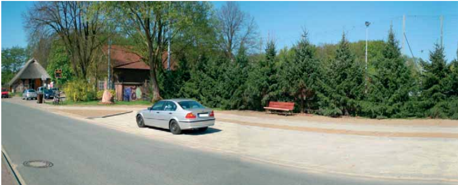
Der neue Parkplatz in der Bahnhofstraße. Zwischenzeitlich sind noch vier neue Bäume dazu gekommen
