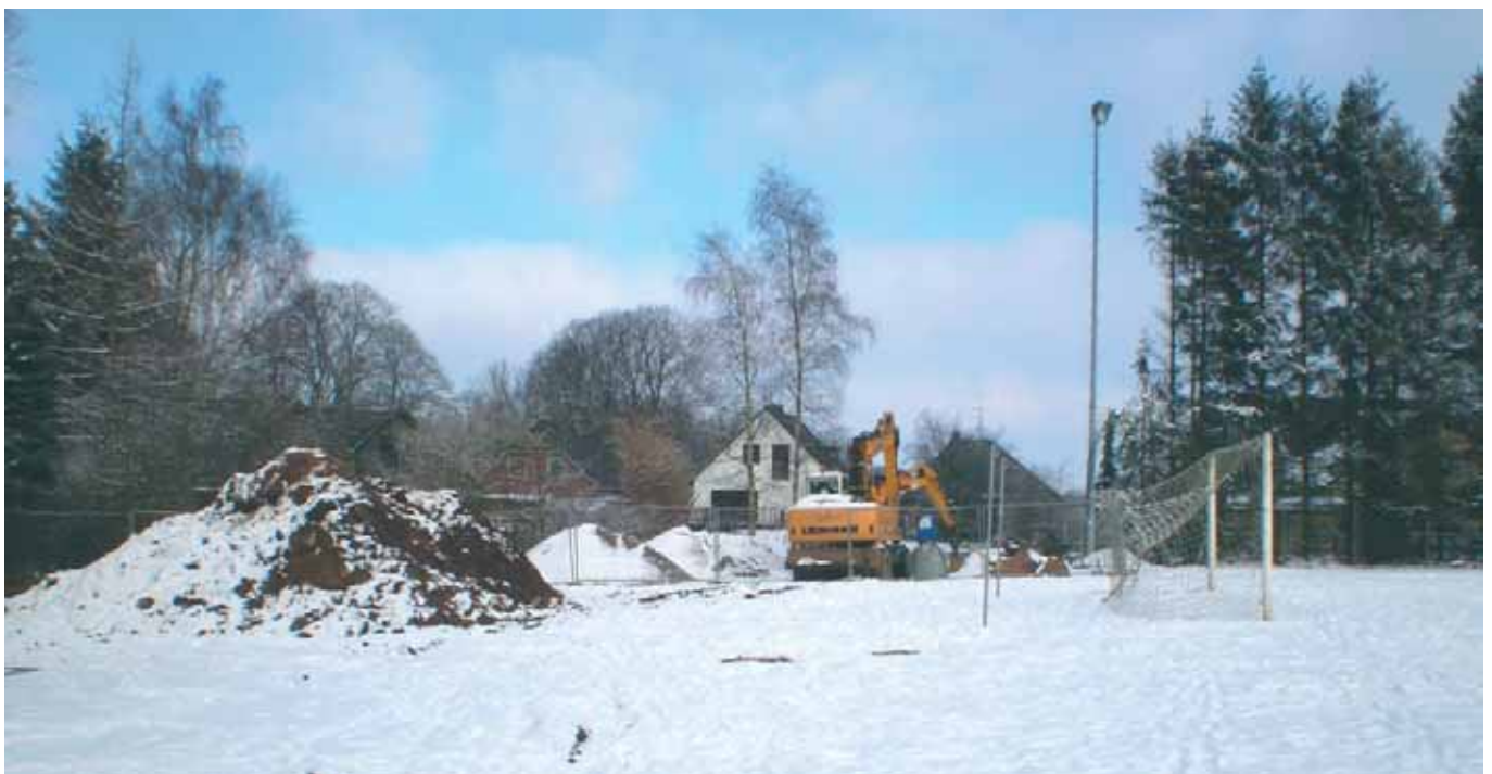
Die begonnenen Bauarbeiten am Regenrückhaltebecken
