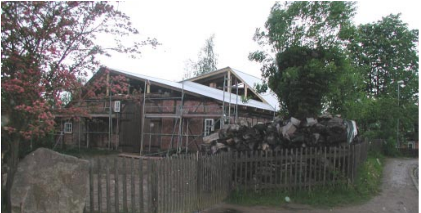
Das Schutzdach über dem Brandhaus
