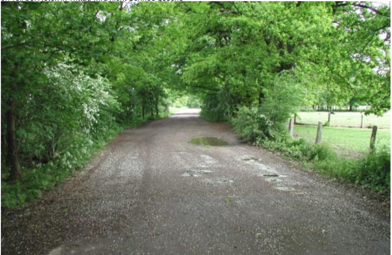
Der Trittauer Teil des Leimbekweges mit den vielen Schlaglöchern
